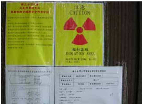
圖一、進出口處設立明顯之輻射警示標誌，並備有緊急聯絡資料及意外事故處理程序於場所入口處及場所內明顯處。
